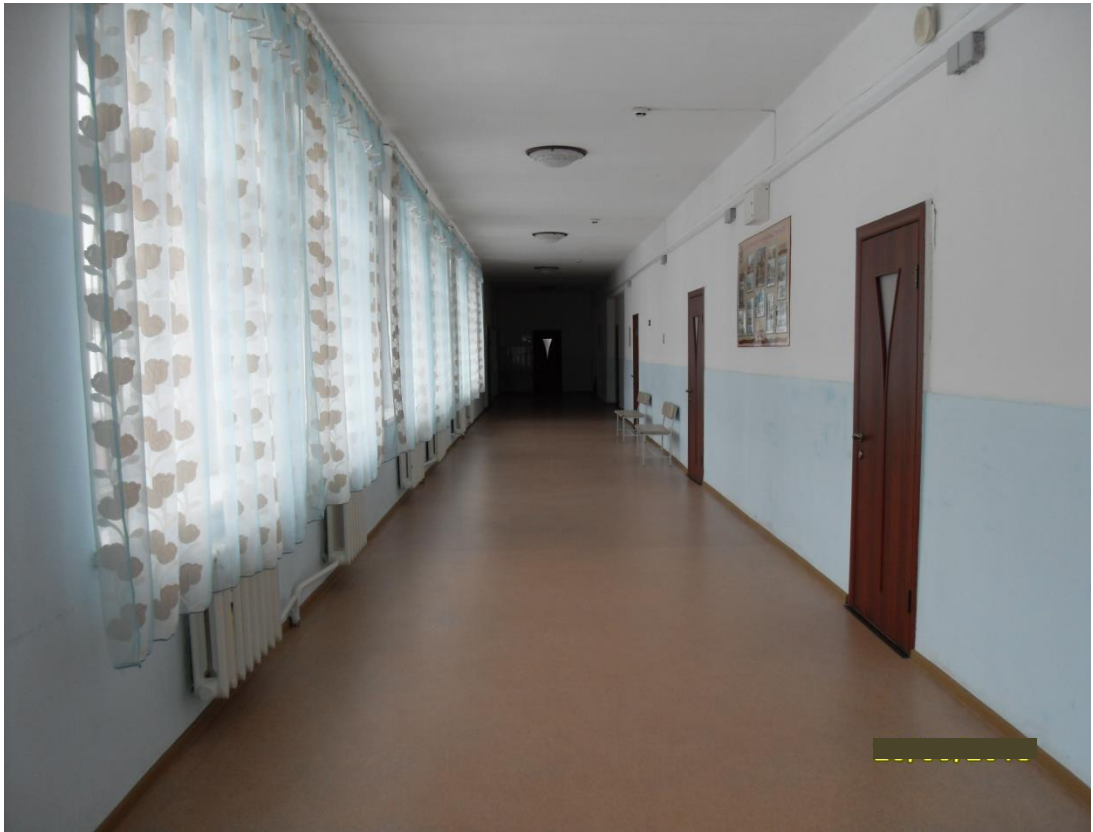
Фото № 23 Пути эвакуации
