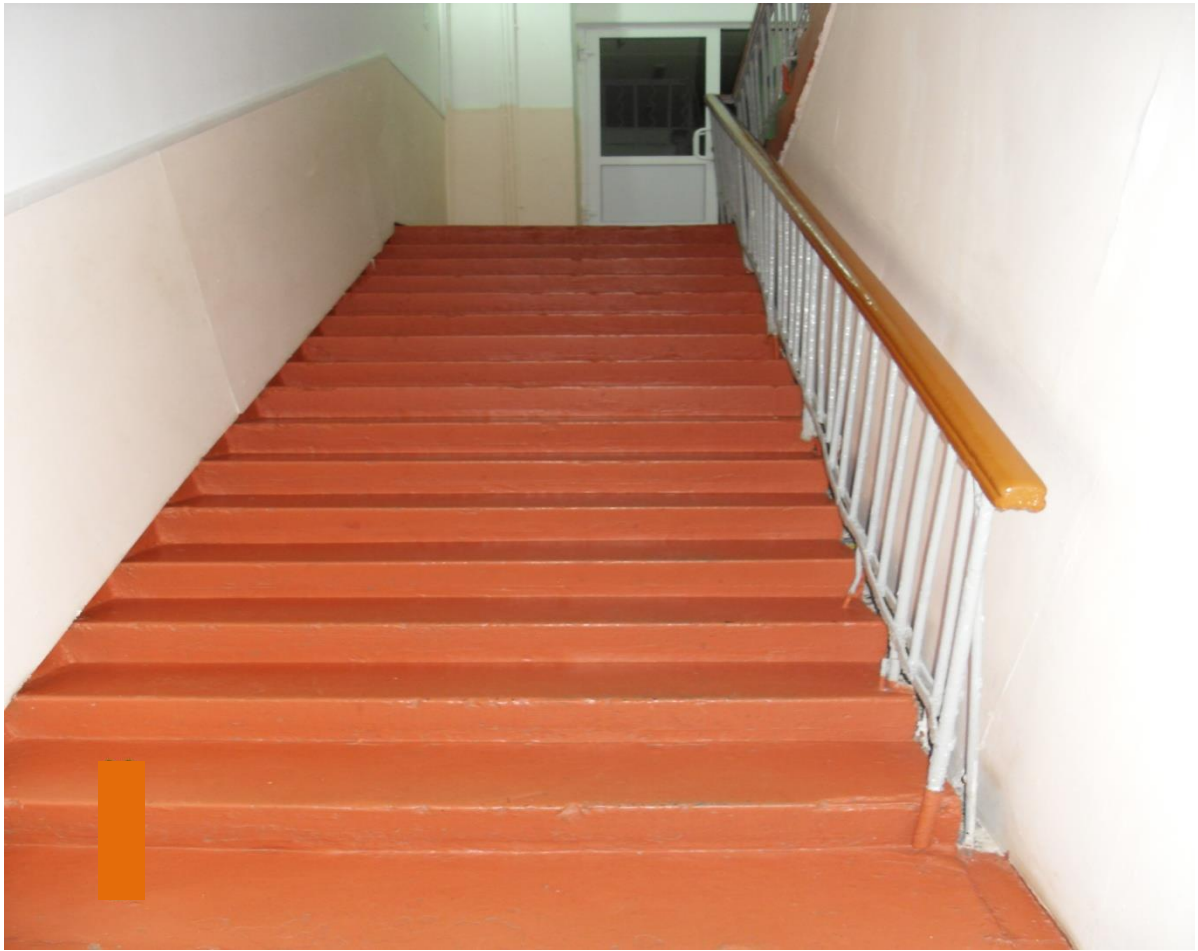
Фото № 17 Лестница внутри здания
